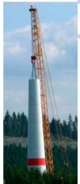
Montaggio della torre prefabbricata in calcestruzzo nel 50 con altezza del tubo 120 m
