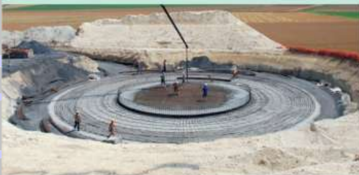
Lavori di armatura della fondazione per il tipo di WEC-E-120
