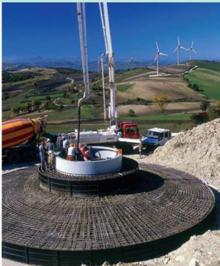
Acciaio di armatura nelle fondazioni standard ENERCON con anelli per tutti le sezioni di attacco ingegneri
